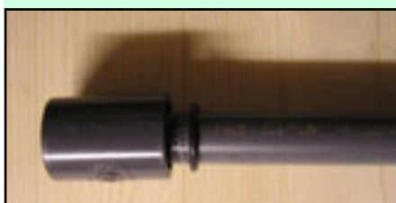
...und die Muffe darüber schieben.
